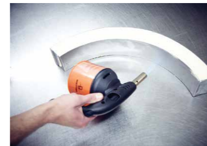
Chauffer le tiers inox préalablement placé en froid négatif à l'aide d'un chalumeau
